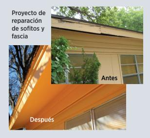
Madera podrida (vigas de soporte, sofitos, revestimiento, etc.) reemplazada con madera nueva y reforzada.
